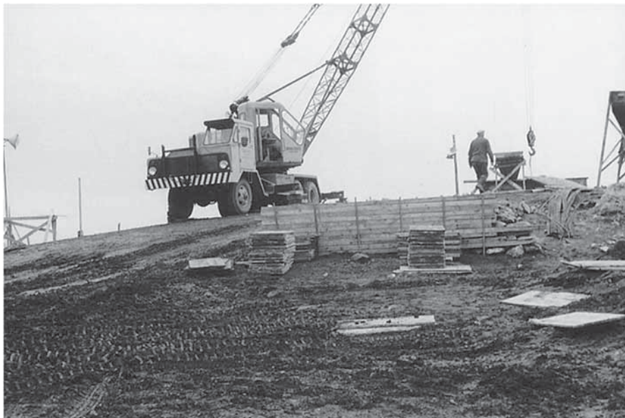
Figur 1.1.6: Mobilkrantypene Wayne-crane og Quick-Wayne ble bygget på amerikansk militærunderstell. De var trekslet, som fagverkskraner med faste bomlengder, og hadde mekanisk drift på alle funksjoner med åpne clutcher og bremsetromler, med fri kobling på alle funksjoner. Kilde: Rogaland kranskole
