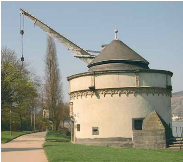
Figur 1.1.1: Fram til 1700-tallet var elva Mosel en travel handelsrute, og denne tårnkranen bygget i 1413 og satt opp i Trierer i Binnenhafen, ble brukt til lastning og lossing av skip. Kranen ble drevet med pedalhjul.
