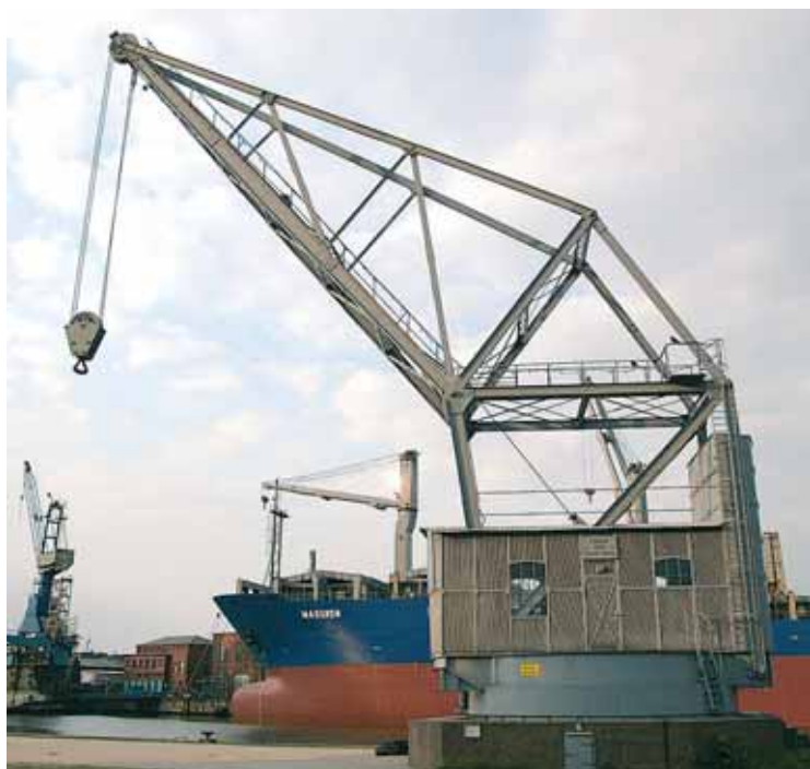
Figur 1.1.4: Her ser vi en trykkvannsoperert svingkran fra 1899. Slik foregriper "vannhydraulikk" den senere bruken av luft og olje. Kilde: Förderverein Maritimer Denkmalschutz e.V., Bremerhaven
