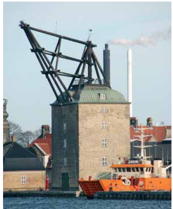
Figur 1.1.2: Kran fra 1742 i København for montering av master på seilskip. Foto: Christopher Leth
